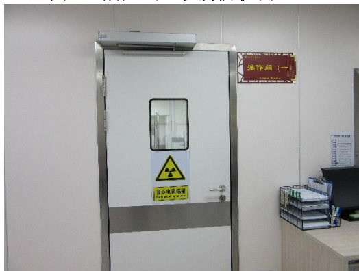
图 3-11 控制室出入机房防护门
